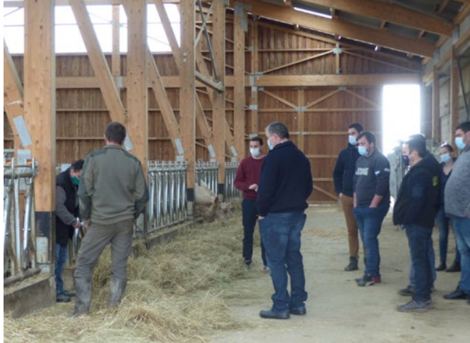
Porte-ouverte chez Xavier CHENU à Servant 48 places, aire paillée + fosse sous caillebotis, faitage ouvert, brise vent. Bâtiment construction bois
