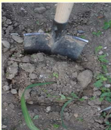
Figure 1 : Creuser la prétranchée
